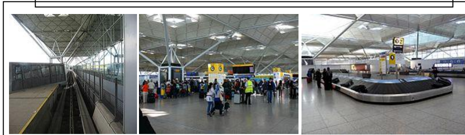
شكل (5) مطار ستانسيد الجديد بلندن لنورمان فستر وبأسفلها المرايات العاكسة للضوء يظهر بالمطار الدعائم الحديدية الشفافة التي تحمل القباب الزجاجية https://upload.wikimedia.org/wikipedia/commons/thumb
