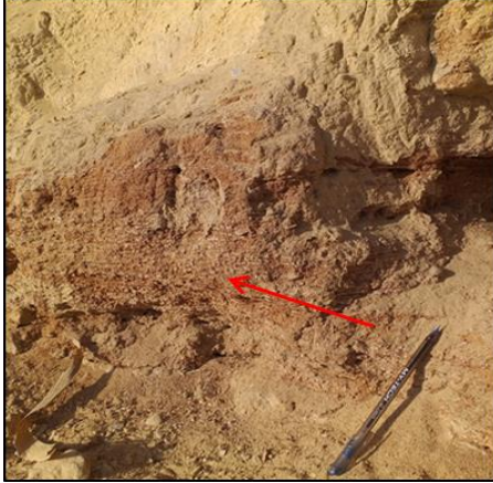
صورة (١٣): الأكسدة بقصر البنات
