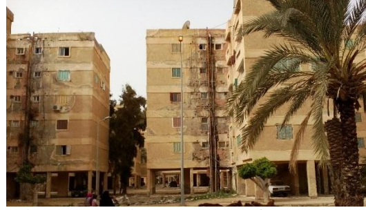
شكل (4) يوضح تآكل الواجهات الخارجية للعمارات السكنية نتيجة تسرب المياه بسبب عيوب تركيب شبكة تغذية وصرف المياه بمدينة العريش.
