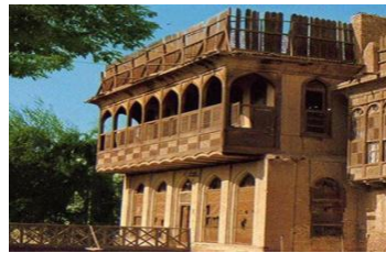
شكل (54) استخدمت الاخشاب كبديل للبعامات الخرسانية
