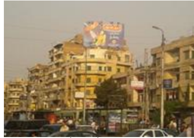
شكل (35) إعلانات كبيرة أعلى الأسطح دون مراعاة لطابع المنطقة
