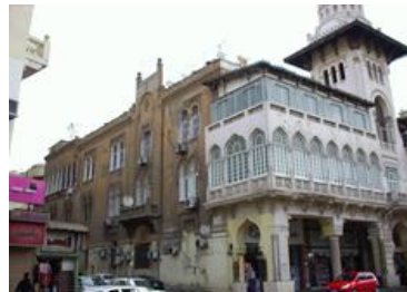
شكل (49) تقفيل أجزاء من المبنى بشكل مشوه ووجود أجهزة التكييف و الدش بالواجهات
