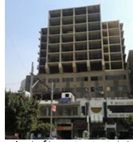
شكل (38) مباني دخيلة على طابع المنطقة بكتل خرسانية
