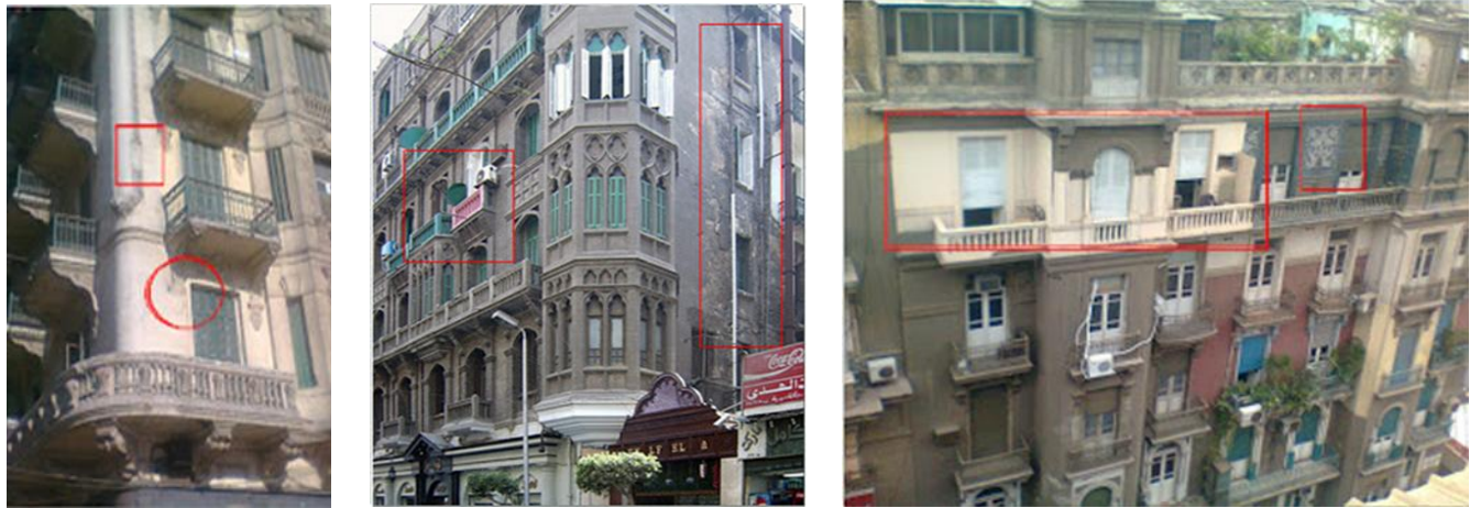
شكل (21) يوضح تنوع الدهانات للمبانى ذو الطابع مما شوه المنظر العام للمبنى شكل(22) عدم وجود صيانه أدى للتأثير على واجهاته شكل (23) سقوط الزخارف وعدم صيانتها
