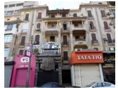
شكل (45) المحلات بالأدوار المتنوعة بالمباني تشوه المباني بشارعى ابراهيم اللقانى
