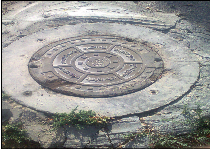
صورة (١٦) : نموذج لمنفذ تصريف المياه الجوفية بالحي السابع كحل رسمي من قبل جهاز المدينة.
