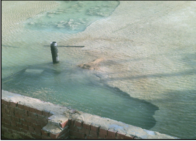
صورة (٩) : يظهر المياه الجوفية في حفر الأساسات ويقوم بعمليات الشفط في بلاعة الصرف الصحي (ش أحمد حمدي- المنطقة الأولى- الحي السابع).
