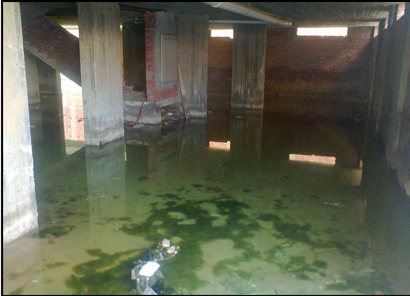
صورة (١٠) : ظهور المياه الجوفية في البدروم بعد إتمام البناء والسكن به في الأدوار الأعلى.
