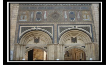
صورة توضح المدخل الرئيسي للجامع
