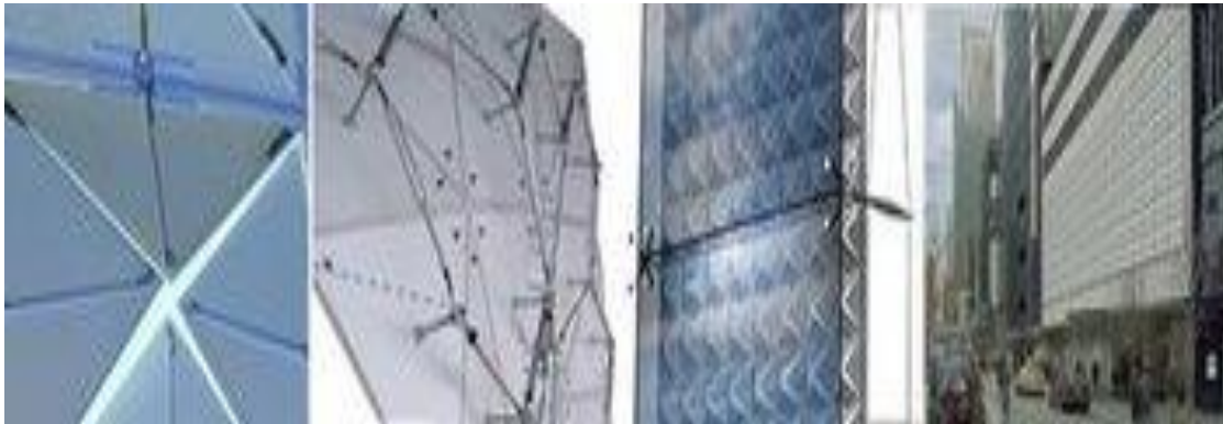
شكل (8) : يوضح صور Pixel skin02 والبلاطة تتكون من أربع مثلثات تحركها أسلاك من سبائك ذاكرة الشكل (SMA) .
