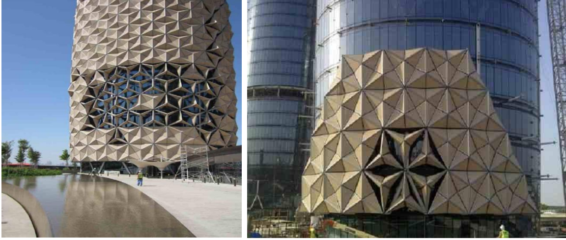
شكل (10) : يوضح الواجهة ترابط الألواح مع القضيب الخشبي لانتاج حركة ديناميكية مختلفة.
