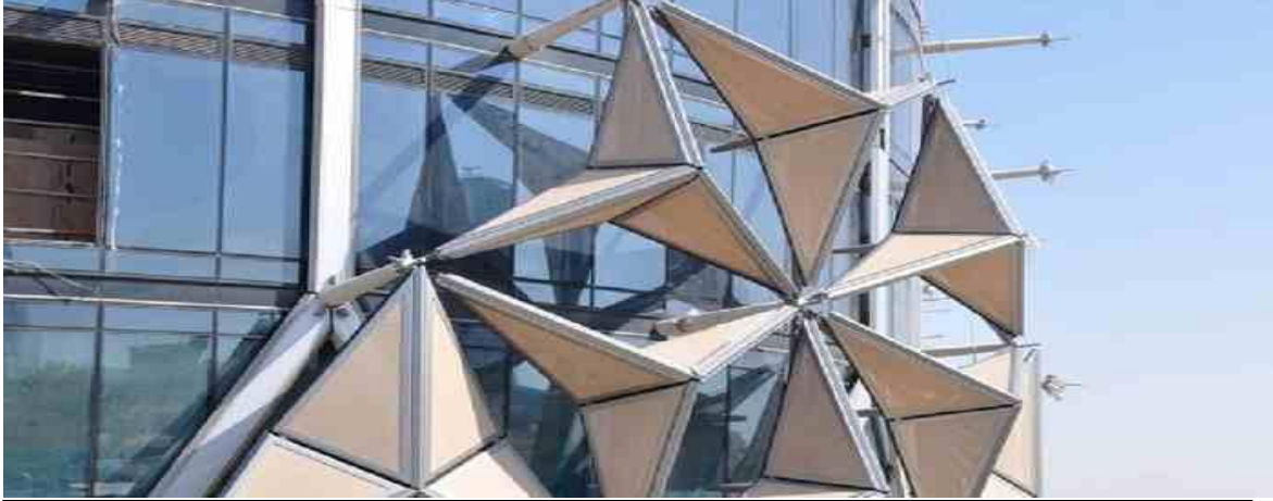
شكل (12) : يوضح نظام المشربية وطريقة تركيبها على الواجهة.
