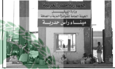
صورة (28) ميناء رأس حدربة البري
