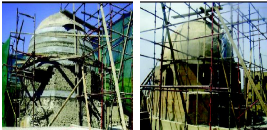
شكل رقم (7)،(8) توضح تسوية سطح القبة ووضع الطبقة التحضيرية سيكاتوب 112 المصدر: (مجد العمارة الإسلامية)، كتاب، 2002- 2006
