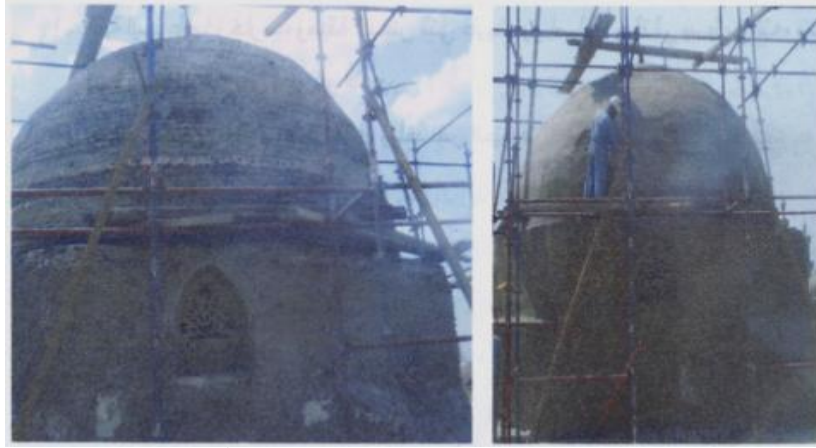
شكل رقم (6) لقطات لتكسير البياض الخارجي للقبة المصدر: المكتب الفني لمشروع القاهرة التاريخية
