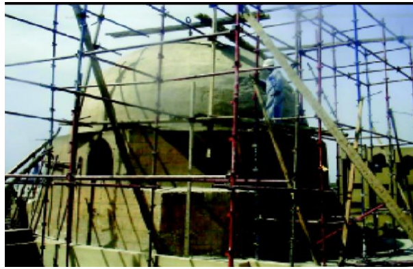
شكل رقم (16) توضح اعمال البياض بعد تركيب شرائح الكربون فايبر لاستعداداً لطبقة الدهان المصدر: القاهرة التاريخية (مجد العمارة الإسلامية)، كتاب، 2002- 2006
