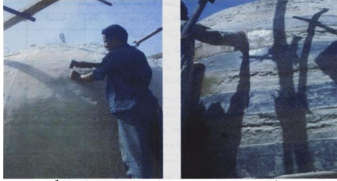
شكل رقم (14)، (15) توضح لقطات للتحضير سطح القبة لدهانها المصدر: المكتب الفني لمشروع القاهرة التاريخية
