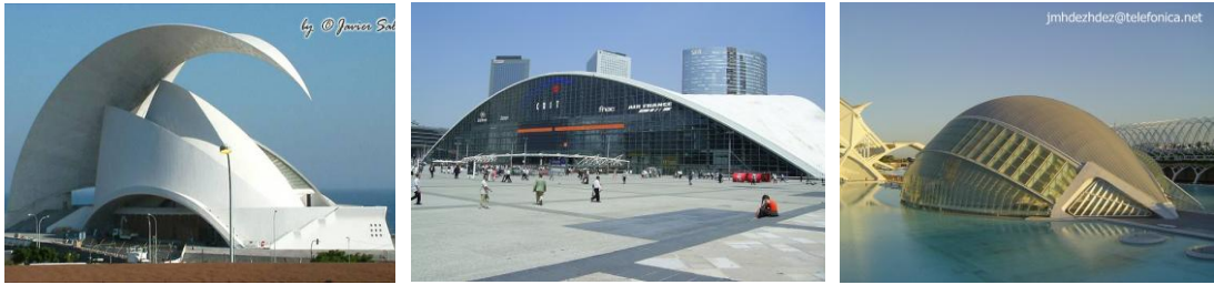
شكل (8) أشكال مختلفة من الإنشاء بالقشريات الخرسانية توضح تطور الإمكانيات الإنشائية الفراغية لهذا النظام من الإنشاء (المصدر: www.structurae.net )
