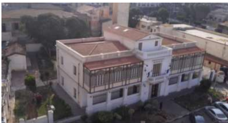
شكل رقم (١) منظر عام لمبنى القنصلية الفرنسية ببورسعيد (تصوير الباحثان)
