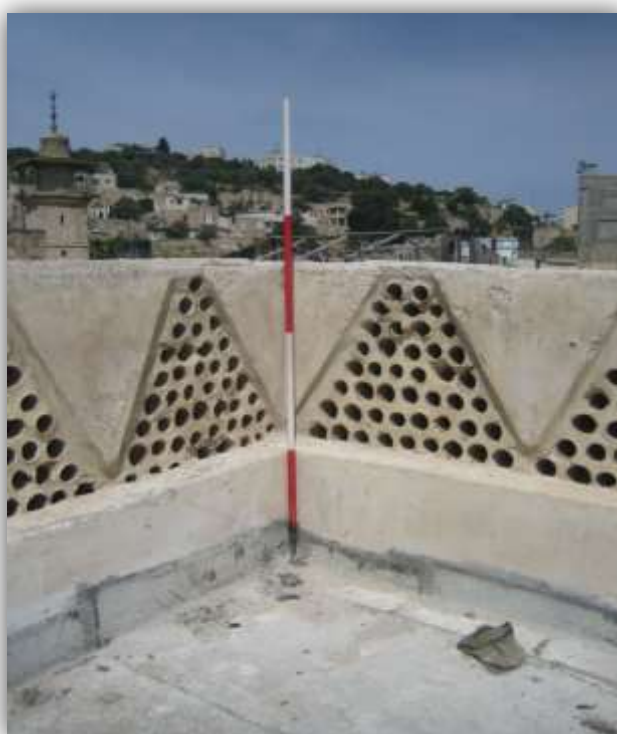
لوحة "٤": تصويوة منزل آل العويوي و استعمال الفخار لحجب الرؤيا ويظهر أيضا ارتفاع التصويوة والمشربية
