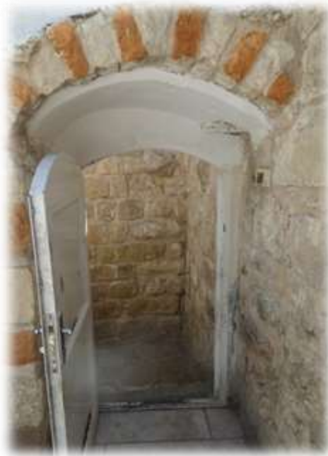
لوحة ١٥ أُخذت من داخل الفناء توضح المدخل.
