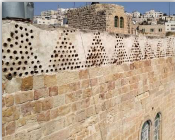
لوحة "٦": فكرة المشربيات على تصوينات الأسطح في البلدة القديمة والتي تحجب الرؤيا بشكل فني ( المصدر: الباحث )
