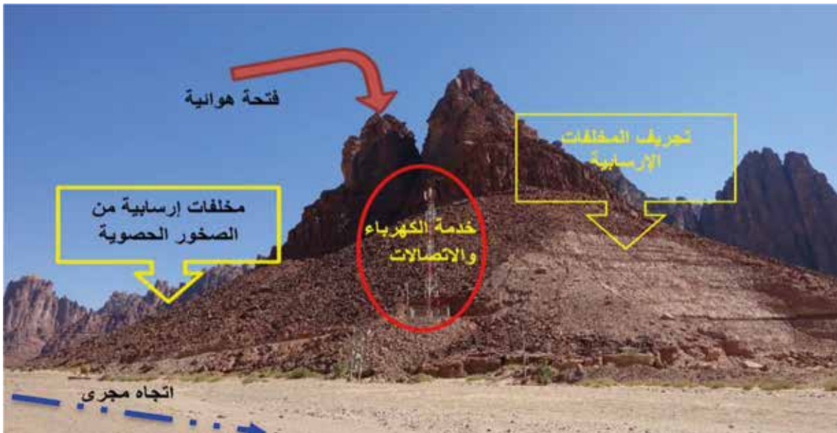
شكل ١٢. وجود خدمة الكهرباء والاتصالات في المنطقة، والتي تسببت في إلحاق الضرر بالأشكال الجيومورفولوجية (المصدر السابق).
