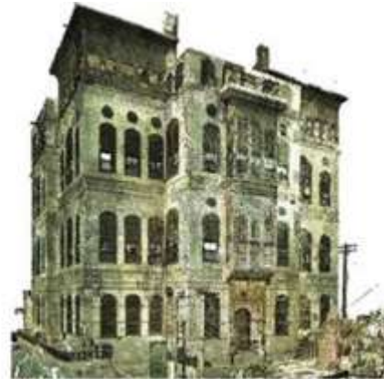
شكل (٣): يوضح مجسم لبيت ناصيف التاريخي بمدينة جدة مخرج من الماسح الليزري علي اليمين، ونموذج الـ "BIM" لنفس البيت علي اليسار عن
