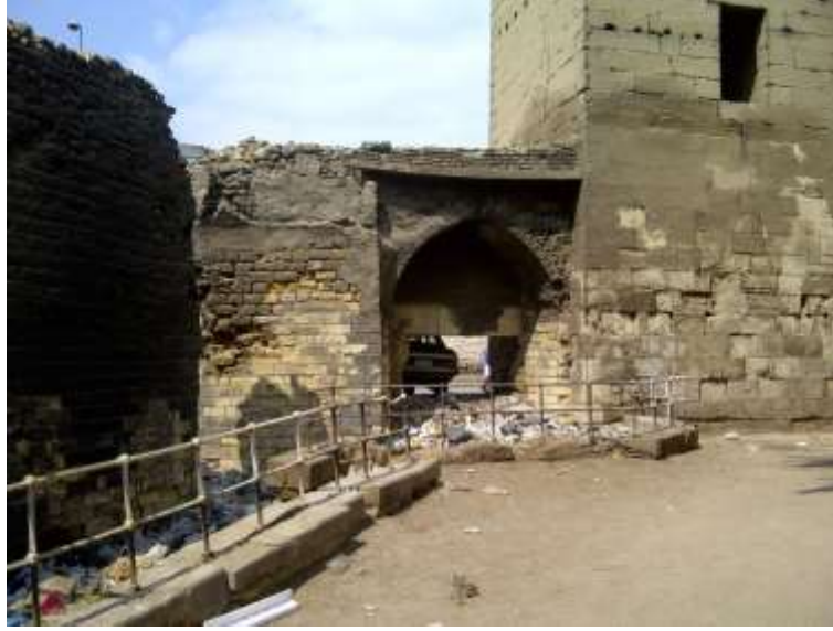
صورة (٤): مدخل تربة فاطمة خاتون من الداخل (تصوير الباحثة)
