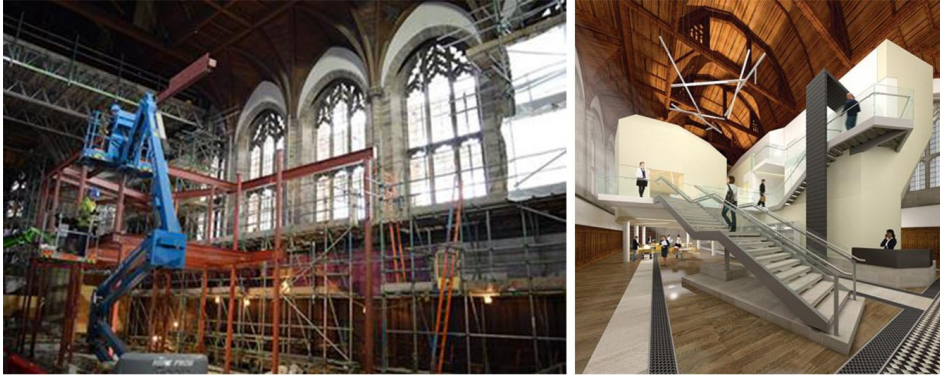
شكل ( ٤ ) المراحل التنفيذية لتشييد الهياكل ذات الإطار الفولاذي داخل كنيسة آل سولز في بولتون Souls Church in Bolton و شكل الوحدات بعد التنفيذ
