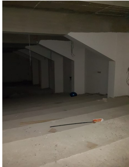
شكل رقم (7) ويظهر فيه المعوقات من الارتفاع المنخفض للسقف والكوابيل الخرسانية والجسور المبالغ في سقوطها
