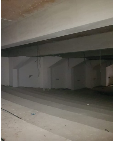
شكل رقم (7) ويظهر فيه المعوقات من الارتفاع المنخفض للسقف والكوابيل الخرسانية والجسور المبالغ في سقوطها
