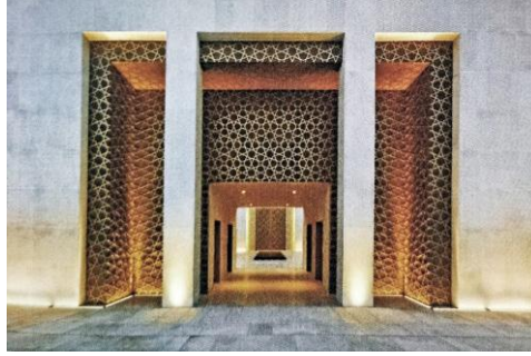
صورة (٤) تطبيق الاتزان المتمائل في المساجد في العصر الحديث.مسجد الجمعة بالدوحة. (Us.archello.com)
