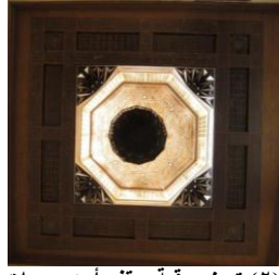
صورة (٢) توضح قبة سقف أحد حجرات البيت السحيمي مستخدما الشكل الثماني. (محسن، ٢٠١٦) ص٥٠.
