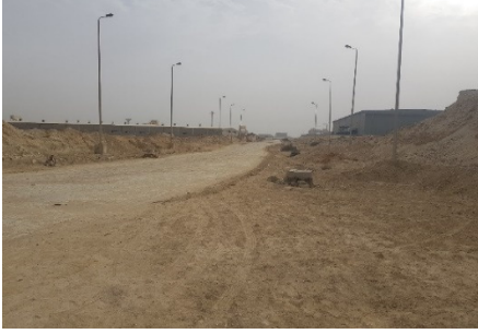
صورة (٨) : عدم رصف بعض الطرق داخل منطقة كوم أبو راضي الصناعية.
