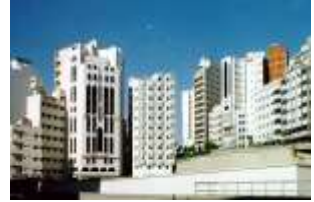
(شكل 4) يوضح بعض المباني الموجودة بالقرب من الحرم الشريف بمكة وقد تم بناؤها بأساليب بعيدة عن الطابع التاريخي أو التراثي ومعالجات للوجهاً والفتحات غريبة عن الطراز الإسلامي.
