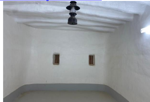
توضح الصورة (5) أحد الغرف الداخلية بقصر العان سقفه من جذوع الأشجار مغطى بمادة النورة ذات اللون الأبيض والتي تغطي جزء كبير من المبنى من الخارج والداخل وهي مادة وظيفتها تعمل على حماية أسطح المباني من مياه الأمطار التي تؤثر على مادة الطين وكذلك لها وظيفة جمالية لتزيين المباني وبعض الأدوات الحرفية تستخدم للطهي والتقديم من خامات البيئة تصنع من الحجر وسعف النخيل (الباحثون، 2021م)
