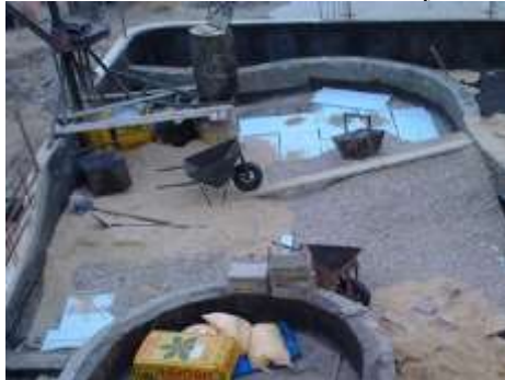
شكل (15) عازل حرارة للتربه سمك اقل من 20 سم
