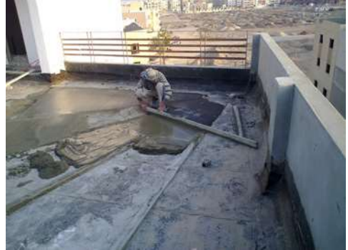
شكل (11) مرحلة تنفيذ خرسانة الميول
