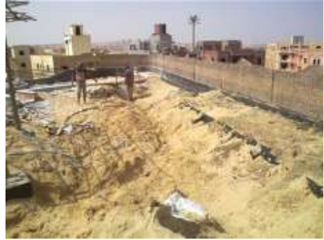
شكل (16) طبقة التربة الزراعية
