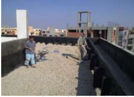
شكل (13) طبقة زلط فولى لتصريف المياه
