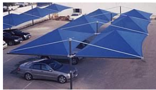
شكل (17) مظلة مجمعة تتكون من وحدات كابولية متكررة من القطاعات الحديدية وسقف التغطية عبارة عن إطارات معدنية فراغية مكونة من وحدات هرمية الشكل شُدت عليها أغشية التغطية . المصدر: (www.pinterest.com)
