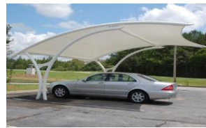
شكل (16) مظلة مفردة تتكون من وحدتين كابوليتين تتصل بعوارض أفقية من القطاعات الحديدية لتكون الهيكل الإنشائي للمظلة والغلاف عبارة عن غشاء نسيجي مشدود من الألياف الصناعية . المصدر: (www.pinterest.com)
