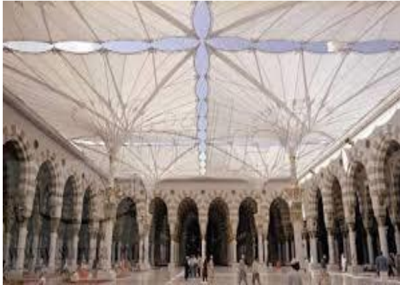
شكل (30)- العناصر الإنشائية للمظلات. الأعمدة والأعشبية المشدودة إلى الأزرع الكابولية للمظلات .
