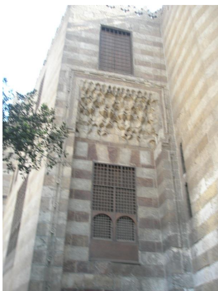
( شكل رقم ١٩ ) اعلى واجهة المدخل من شباك من خشب الخرط يعطوه مقرنصات
