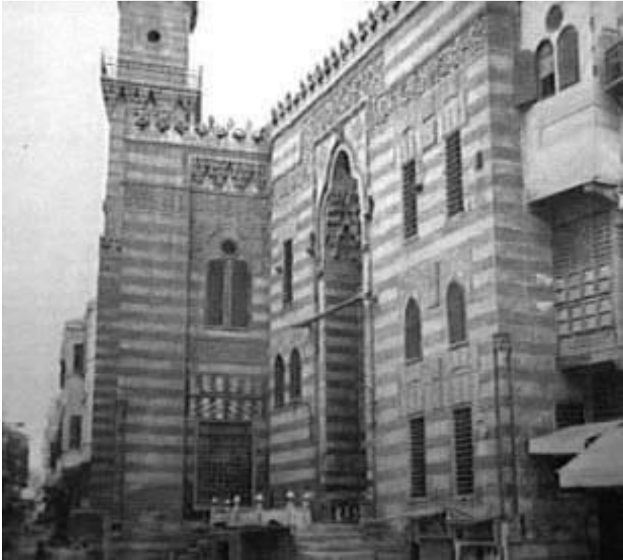
(شكل رقم ٥) صور قديمة لواجهة مدرسة الغورى ويظهر بها قاعدة المأذنة ٩٥ .
