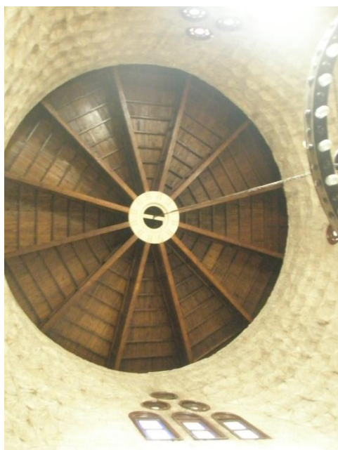
(شكل رقم ١٢) القبة من الداخل وهي مندثرة ومغطاه بسقف خشبي
