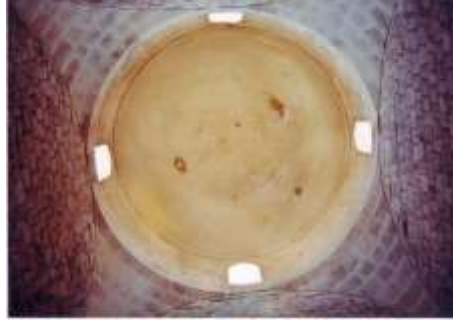
(لوحة 23) تربة ابن أعلبك: منطقة الانتقال ورقية وخوذة القبة من الداخل
