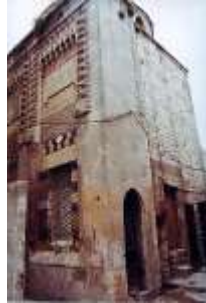
(لوحة 13) تربة ابن أغلبك: الواجهة الشمالية ويظهر القسطل بالطرف الغربي لها
