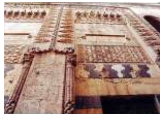
(لوحة 6) تربة ابن أغلبك: المدماك ذو الصنجات المزرة بالدخلة الجنوبية بالواجهة الغربية
