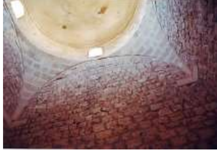
(لوحة 22) تربة ابن أعلبك: منطقة انتقال القبة (المثلثات الكروية)
