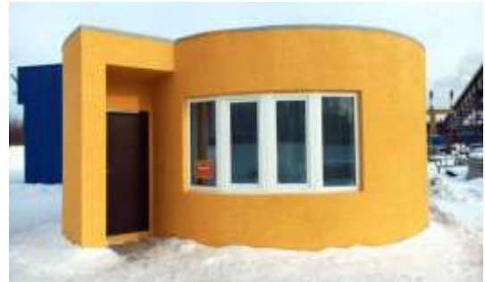
منزل مطبوع باستخدام رغوة الخرسانة والبولى يوريثين السائل للعزل الحرارى بالفراغات جنوب موسكو بروسيا مساحتة 38م 2 فى عام 2016م وذات أرضيات خشبية مع أجهزة من شركة سامسونج وكانت تكلفته هي 10.150 دولار تقريباً
