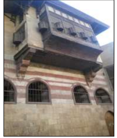
شكل (8) يوضح تنوع الفتحات المعمارية ما بين مشربيات وشبابيك ذات مصبغات حديدية واسعة وأخرى ضيقة إلى جانب شبابيك زجاجية
