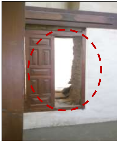
شكل (7) يوضح عدم احترام القيمة الوظيفية عند إعادة ترميم بعض عناصر الفراغ الداخلي (الدواليب الحائطية) بالقاعة العلوية
