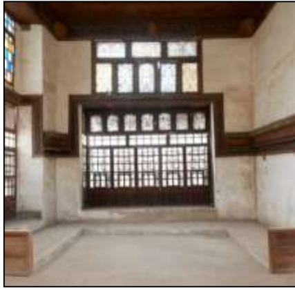
شكل (8) يوضح تنوع الفتحات المعمارية ما بين مشربيات وشبابيك ذات مصبغات حديدية واسعة وأخرى ضيقة إلى جانب شبابيك زجاجية
