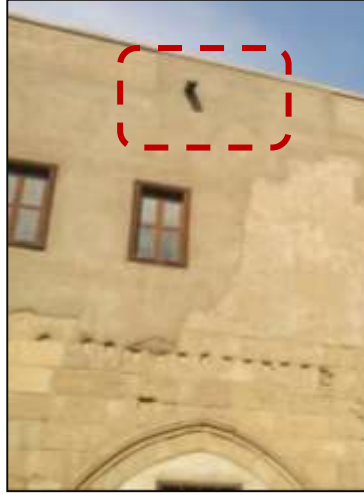
شكل (12) يوضح مصارف المياه بسطح البيت
