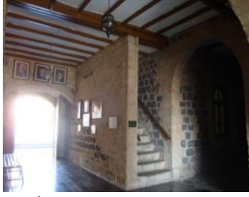
صورة (٩) الى اليسار، السقوف المستوية بعد الترميم.
