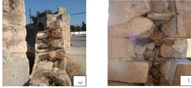
صورة (١٤) إحدى جدران بيوت إربد القديمة المحيطة بدار السرايا، تبين طريقة بناء الجدران باستخدام الطين والحجر في تلك الفترة.
