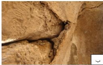
صورة (١٣) إحدى جدران بيوت إربد القديمة لم يتم ترميمها، المحيطة بدار السرايا، استخدام الطين المخلوط بالماء والتبن، لتكوين خليط متماسك للربط بين مداميك الحجر.
