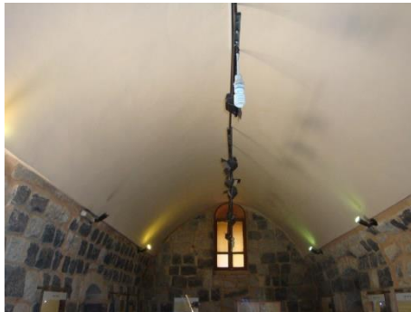
صورة (٧) السقوف النصف برميلية في أسقف المبنى
