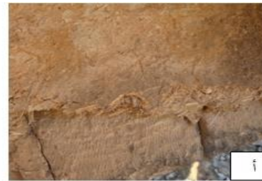
صورة (١٣) إحدى جدران بيوت إربد القديمة لم يتم ترميمها، المحيطة بدار السرايا، استخدام الطين المخلوط بالماء والتبن، لتكوين خليط متماسك للربط بين مداميك الحجر.
