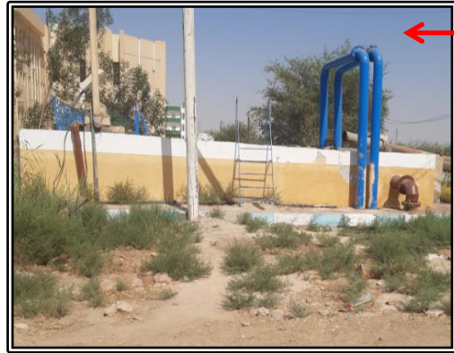
صورة (٥) خزان المياه النقية في محطة مياه الأمل.
