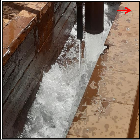
صورة (١٠) التخلص من رواسب الحديد بعد عمليات المعالجة في محطة السيط الشرقية.
