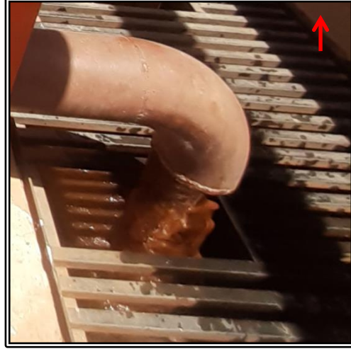
صورة (٩) زيادة نسب الحديد الناتجة من عملية أكسدة المياه بمحطة البساتين (٢).
