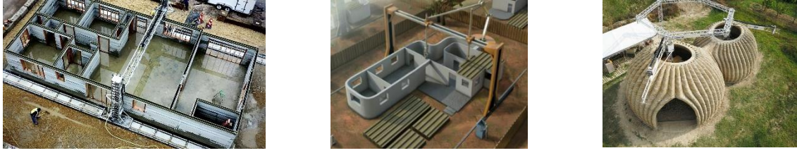
شكل (١٢) الطباعة ثلاثية الأبعاد وتقنية صب الخرسانة باستخدام الميكنة دون الحاجة إلى عمالة المصدر تقنيات+طباعة+المنازل+ثلاثية+الأبعاد+q https://www.google.com/search?q
