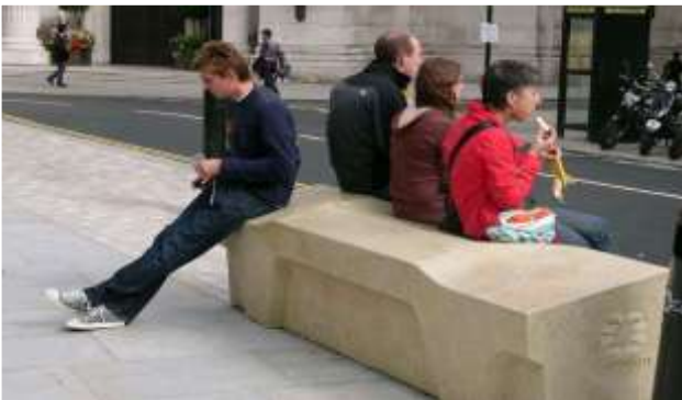
Fig. 29 - مقعد Camden بلندن من أشهر التصميمات الدفاعية للمقاعد، صُمم ليمنع عدد كبير من الأنشطة كالتالي: *مصنوع من مادة إسمنتية مصممة لا يوجد به فراغات لتلافي تكسره وتفكك أجزاؤه. *أسطح المقعد مصقولة لجعله زلقاً فيصعب النوم عليه.
