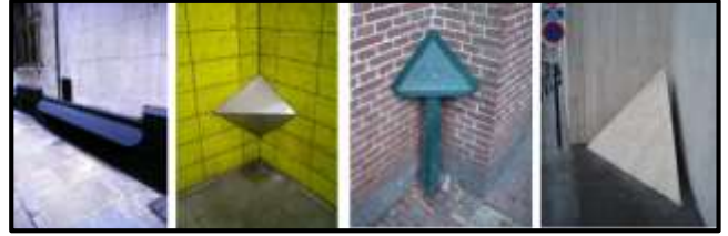
Fig.27 - بعض أشكال عاكسات الرزاز المثبتة في أركان وزوايا المباني بالأماكن العامة والمتنزهات؛ ويظهر بالصورة الأخيرة عاكس رزاز مثبت على كامل جدران أحد المباني بالعاصمة البريطانية لندن
