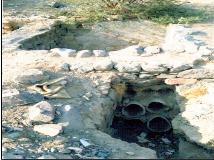
(لوحة 5) عين الخيف ويظهر فيها أنابيب نقل المياه
