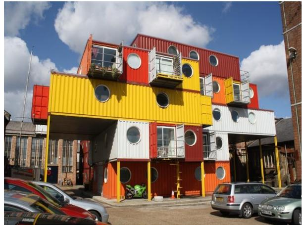
شكل 30، مدينة لندن للحاويات Container City ومقرها مدينة لندن و يوضح الرسم طريقة تراكب وتحميل الحاويات في كل طابق. . (Uzoezi, 2016)
