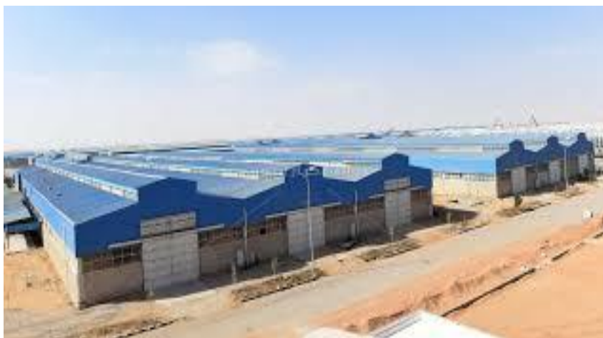
صورة رقم (٣) توضح شكل الهناجر المخصصة لدباغة الجلود داخل الروبيكي
