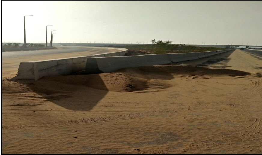
صورة (٢) : حركة الرمال على طريق أكتوبر / الواحات، بتاريخ ٢٠٢١/٦/١٢م، "ناظرا صوب الجنوب الغربى".
