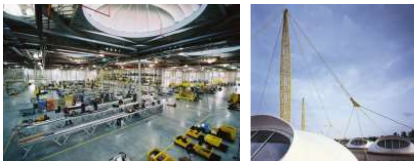
صورة رقم (3) مصنع Iguazú بألمانيا Germany ومراعاة الأسس الإيكولوجية في التصميم، من خلال إتجاه حركة الشمس في عمل الفتحات بالسقف للإستفادة من الإضاءة الطبيعية الشمالية بتكلفة إقتصادية قليلة من خلال إستخدام خامات خفيفة في التصميم (21) .
