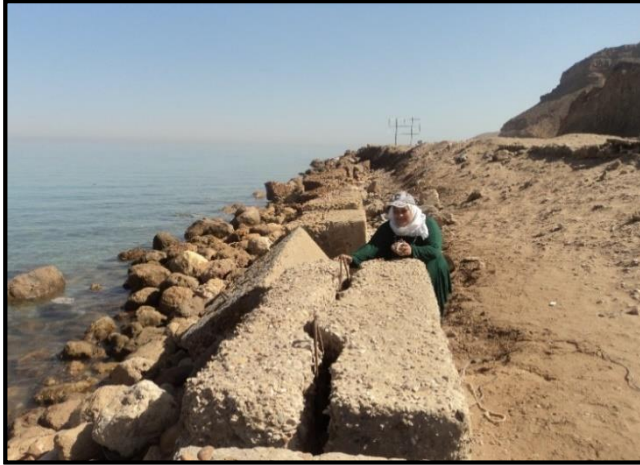
شكل (٣٧) استخدام الكتل الخرسانية في حماية السواحل الجرفية من التآكل جنوب رأس أبو درج - ناظراً صوب الجنوب الغربي
