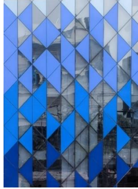
شكل (29): مثال على التغطية شبه المنتظمة. مبنى مكتب Tri-Tessellate في نويدا، الهند صممه مكتب أميت خان.
