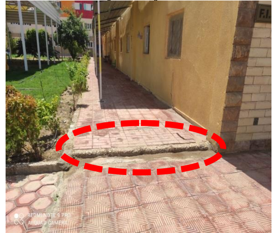
شكل (6): وجود فرق منسوب بين مسارات الحركة لم يتم تصميمها كمنحدر, (تصوير الباحث).
