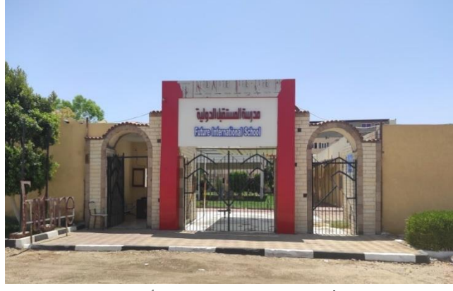
شكل (8): عدم توفير منحدر لصعود الرصيف أمام المدخل الرئيسي للمدرسة, (تصوير الباحث).
