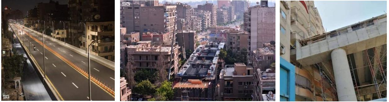
أشكال (56-57-58) توضح الكتل الخرسانية للكباري دون لمسات جمالية في تشكيل الكباري لتكون معلما بالمنطقة
