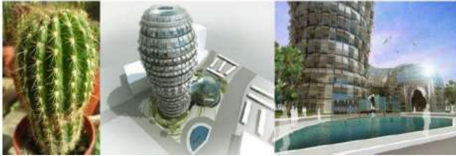
شكل(٨): يوضح مبنى وزارة شؤون البلدية المستوحى من الصبار
