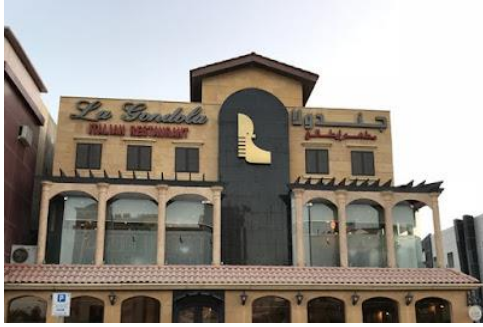
شكل (4) يوضح واجهة مطعم محلي بمدينة الدمام يغلب عليه الطابع المحلي في العمارة المحلية. المصدر (4)
