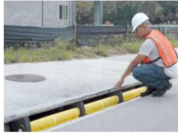
شكل (١٥): استخدام الحواجز لتوجيه مياه الامطار السطحية إلى مصارف المياه [٢]
