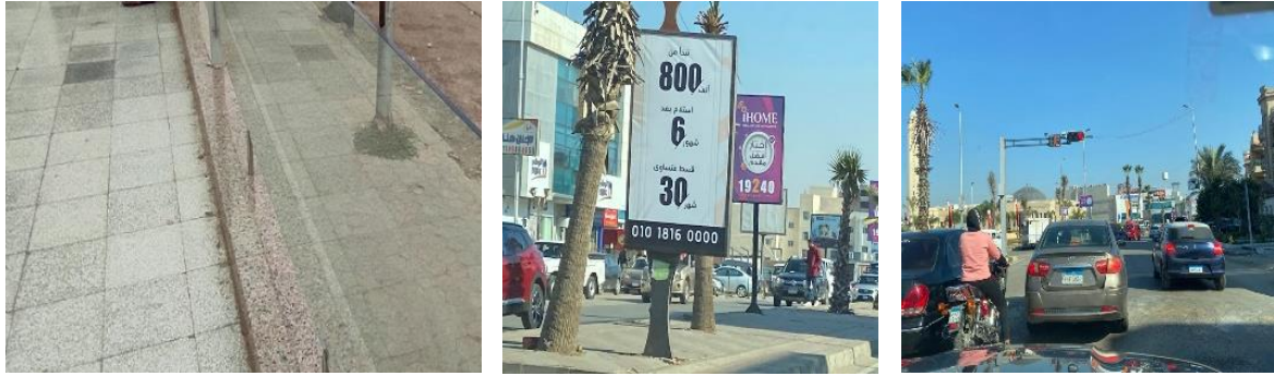
شكل (٣٦): عدم ملائمة معابر المشاة سواء بوضع إعلانات تجارية بصورة مكثفة أو باستخدام مواد نهو مختلفة وغير ملائمة - المصدر: الباحث
