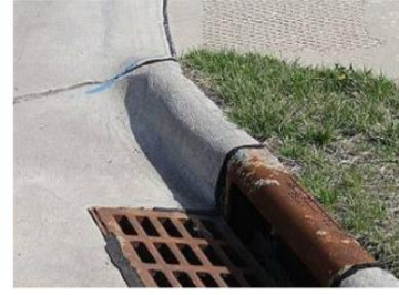
شكل (١٥): استخدام الحواجز لتوجيه مياه الامطار السطحية إلى مصارف المياه [٢]
