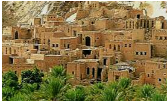
إستخدام مواد البناء الطبيعية في بناء المساكن التقليدية بالواحة.
