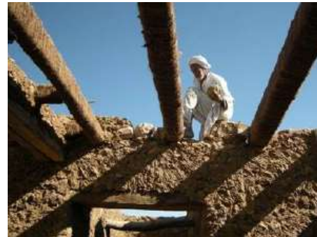
إستخدام مادة الكرشيف، وجريد النخيل في أسقف المباني في بناء المساكن الريفية التقليدية.
