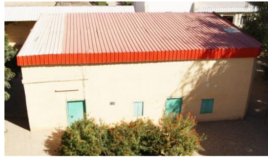
لوحة 79 : منظر عام لديوان القهوة. السقف الزنكي والواجهة الجنوبية . قبل الترميم. تصوير الباحثة 2015م.
