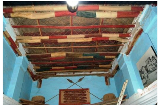
لوحة 49: سقف حجرة العرش من خشب الصهب المغلفة بالجوخ بالألوان المختلفة قبل الترميم. تصوير الباحثة 2015م.
