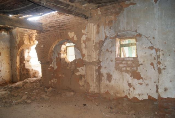
لوحة رقم 110 مخزن السكر وواجهته الجنوبية من الداخل وحالته حاليًا. تصوير الباحثة 2015م.
