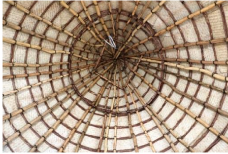
لوحة 70 : السقف المخروطي من الداخل لمبنى الحراسة (1) بعد الترميم 2019م.
