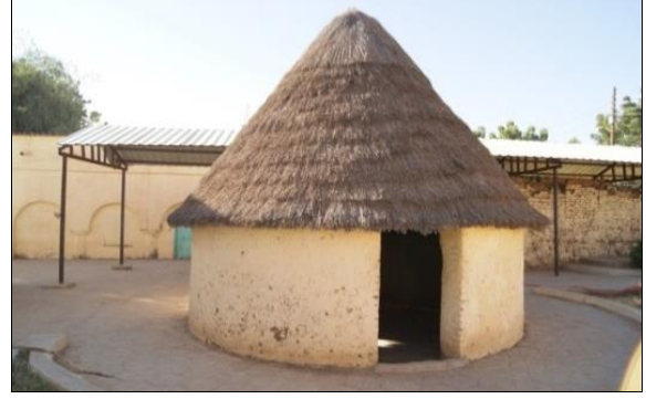
لوحة 67 : مبنى الحراسة (1) قبل الترميم. تصوير الباحثة 2015م.
