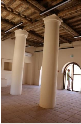
لوحة 88 : عمودي ديوان القهوة والسقف بعد الترميم. تصوير الباحثة 2019م.
