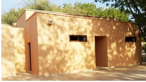
لوحة 86 : الواجهة الغربية بعد الترميم. هناك تغير وإعادة استخدامها كحمامات. تصوير الباحثة 2019م.
