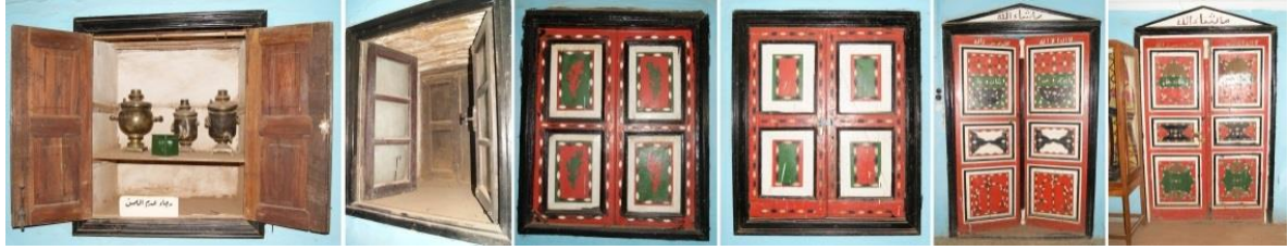
لوحة 46 : أعمال النجارة بحجرة العرش الأبواب والشبابيك والدواليب الحائطية من خشب القميل. تصوير الباحثة قبل الترميم 2015م.
