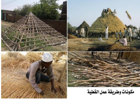
لوحة 4 : طريقة تشييد القطية ومكوناتها. صور مجمعة من الإنترنت.
