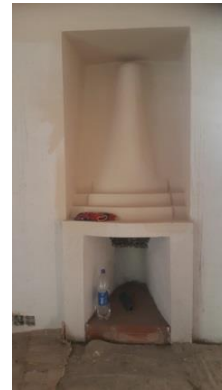
لوحة 53 : المدفأة بالجدار الجنوبي لحجرة العرش بعد الترميم. تصوير الباحثة 2019م.
