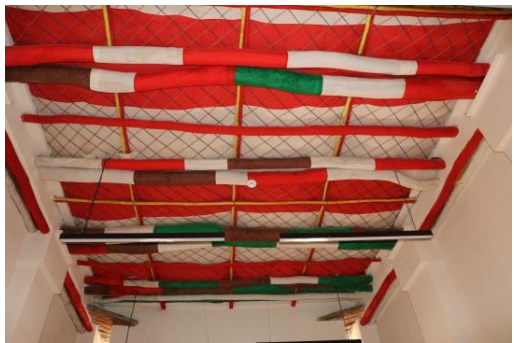
لوحة 50: سقف حجرة العرش من خشب الصهب المغلفة بالجوخ بعد الترميم. تصوير الباحثة 2019م.
