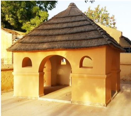
لوحة 72 : مبنى الحراسة (2) الواجهة الغربية والجنوبية بعد الترميم. تصوير الباحثة 2019م.
