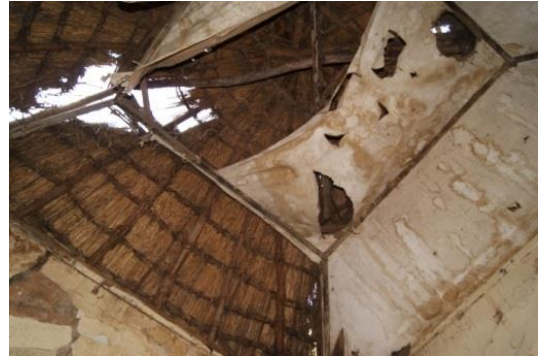
لوحة 77 : تعريشة مبنى الحراسة(2) من الداخل قبل الترميم. تصوير الباحثة 2015م.
