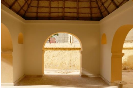
لوحة 76 : الجدران الشمالي والشرقي والغربي لمبنى الحراسة(2) من الداخل بعد الترميم. تصوير الباحثة 2019م.
