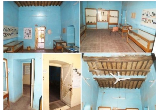
لوحة 55: الحجرة الثالثة وجدرانها وسقفها قبل الترميم . تصوير الباحثة 2015م.
