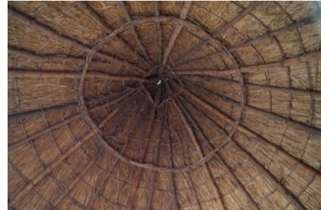
لوحة 69 : السقف المخروطي من الداخل لمبنى الحراسة (1) قبل الترميم. تصوير 2015م.
