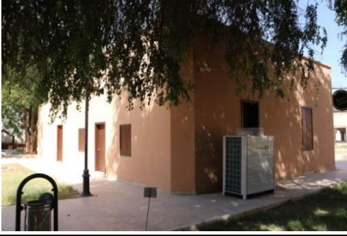
لوحة 84: الواجهة الجنوبية والشرقية بعد الترميم. تصوير الباحثة 2019م.
