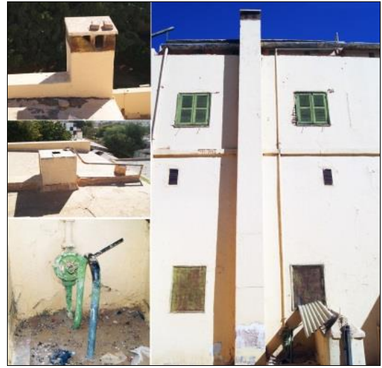
لوحة 43 : عمود مدخنة المدفئة وبروزه العلوي وصهريج المياه أعلى السقف العلوي. تصوير الباحثة 2015م.
