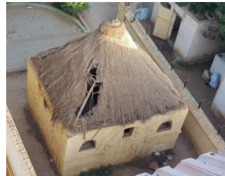
لوحة 73 : منظر عام لمبنى الحراسة (2) وجداريه الشرقي والجنوبي وتكريشته المخروطية قبل الترميم. تصوير الباحثة 2015م.
