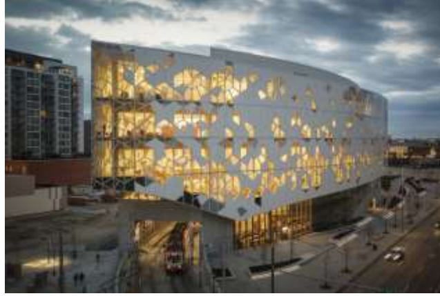
صورة رقم (7) المكتبة المركزية بكندا ، بلغاريا ( الواجهة خرسانة وزجاج ) ، 2018م
