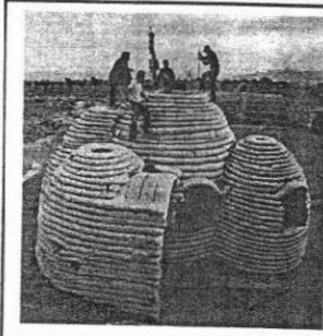
(شكل-5): أحد التجارب لإنتاج مساكن مؤقتة من مواد بيئية للمعماري الإيراني نادر خليلي، وتعتمد على البناء باكياس مملوءة من تربة الموقع بنظام إنشائي معين. [21]
