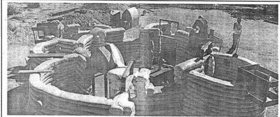
(شكل-20): صورة لعملية إنشاء مبني من أكياس التربة. [21]
