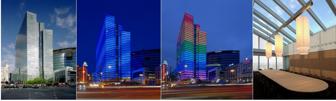
شكل (2-3-4-6): مبنى برج داكسيا في بلجيكا (Daxia Tower).
