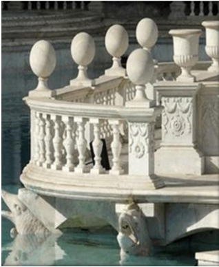
أعمال الرخام بسراى الفسقية
