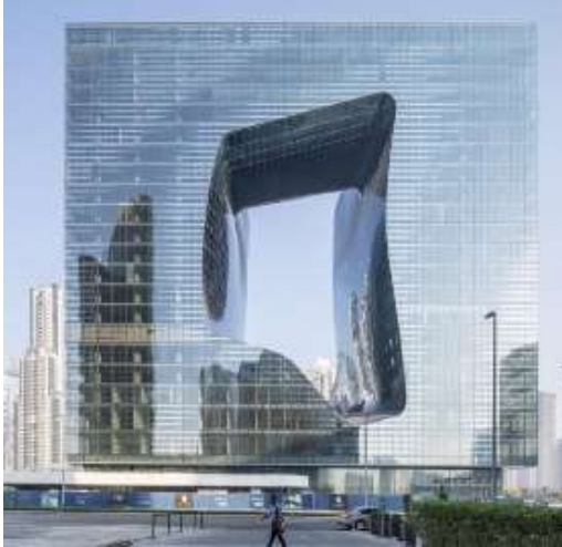
شكل (١١) مبنى أوبوس ، دبي
